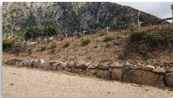
Pour rappel, un point sur les travaux avait été effectué en 2017, en concertation avec le maire et l'entreprise porteuse avant travaux. En effet, le ravinement assez important avait nécessité un renforcement des talus par des enrochements afin de consolider les aménagements présents.
