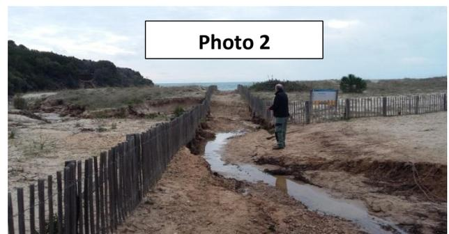
Ces travaux consistent d'une part à reprofiler, de manière mesurée, le lit créé par les écoulements pluviaux exceptionnels, d'autre part à déplacer le sentier permettant d'accéder à la plage, et donc les ganivelles. L'ensemble des réaménagements à prévoir est résumé sur le plan 1 et le croquis 1.
