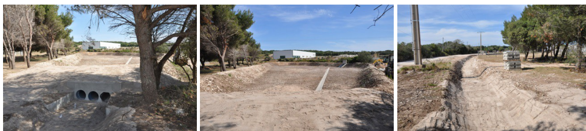
Bassin de rétention (juin 2014)
