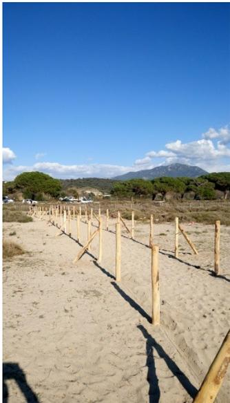
Les travaux effectués en régie par les GDL, ont consisté en la réfection du muret pour créer des ouvertures et en la mise en place de traversées de ganivelles au travers de la Lande.
