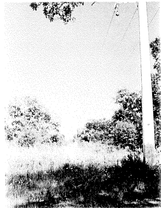
3 - La ligne électrique aérienne alimentant la presqu'île devra être supprimée.
