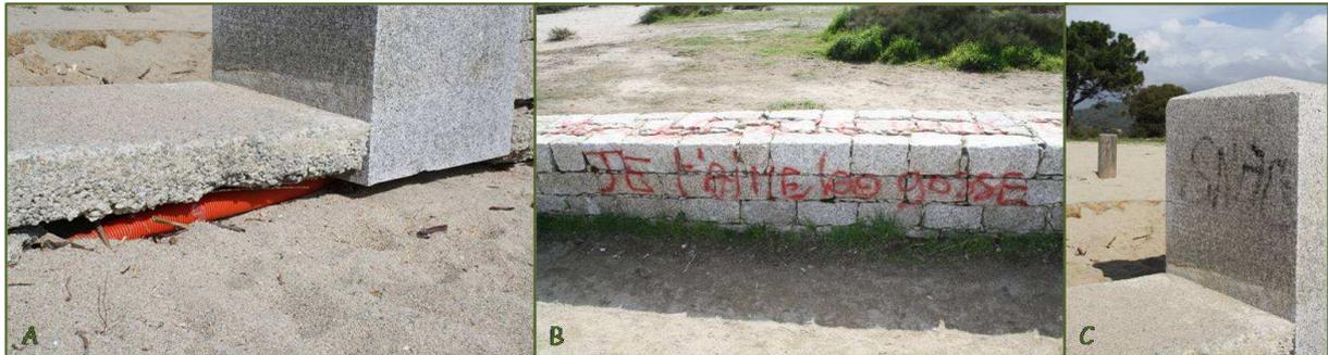
**Figure 44 :** Dégradations observées sur le muret en mars 2010. A : déchaussement de la base du muret côté plage ; B et C : tags.
