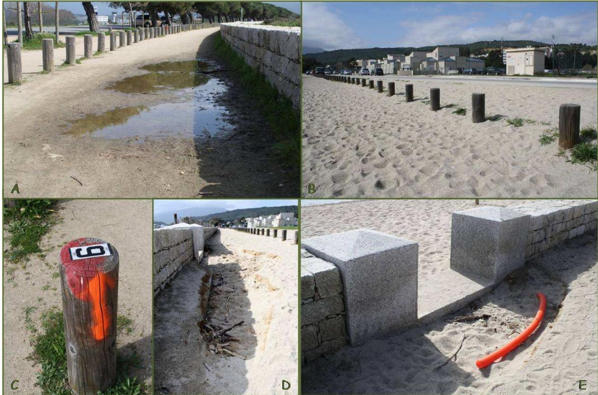
**Figure 41** : Dégradations de la promenade observées en mars 2010. A : flaques gênant la circulation des marcheurs et des joggeurs ; B : sable recouvrant une portion de la promenade et débordant sur la route ; C : pseudo signalétique pour marquer les 100 m le long de la promenade ; D, E : zones d'érosion.
