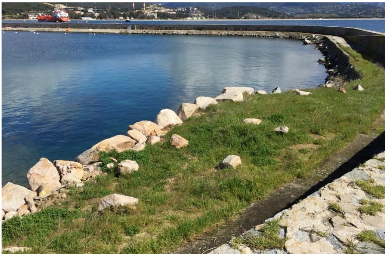
Vue du terre plein au bout de la jetée où ont niché une partie des oiseaux en 2016 ; les travaux de renforcement de 2015 ont bien cicatrisé
